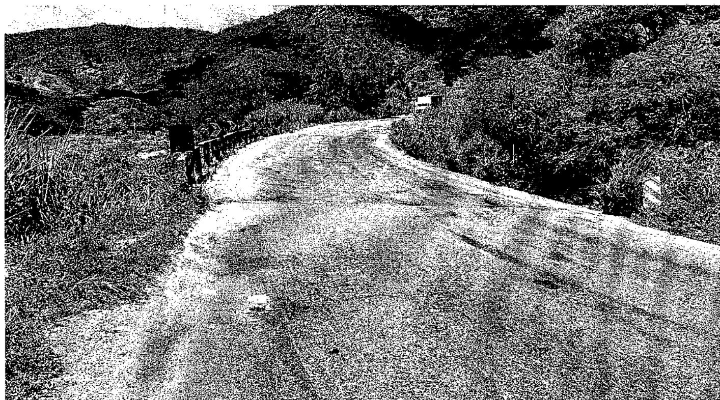
Figura 05: Situação atual – Afundamento Plástico e Trincas em Malha
