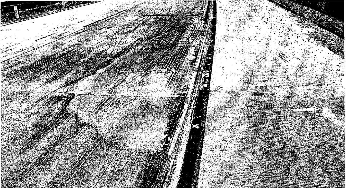
Figura 06: Situação atual – Trinca em Pavimento Rígido
